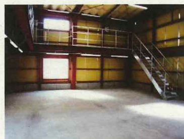
リサイクルセンター内部
