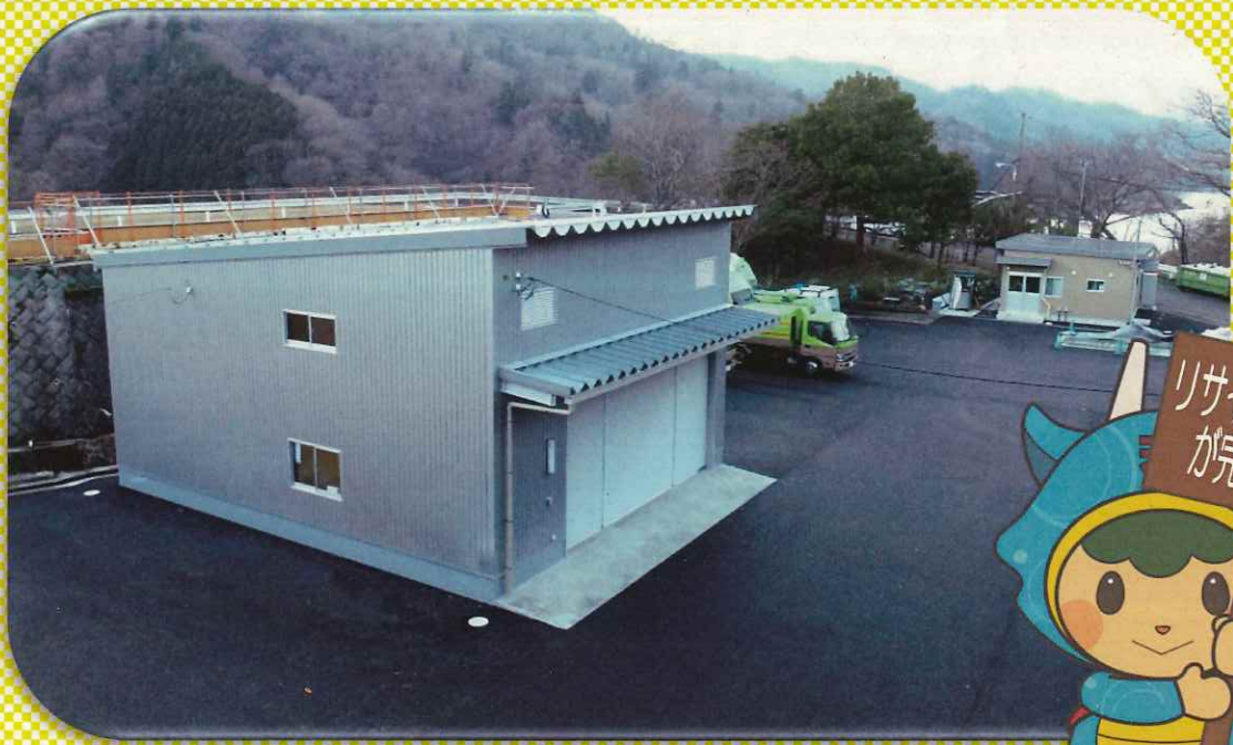
清川村リサイクルセンター
