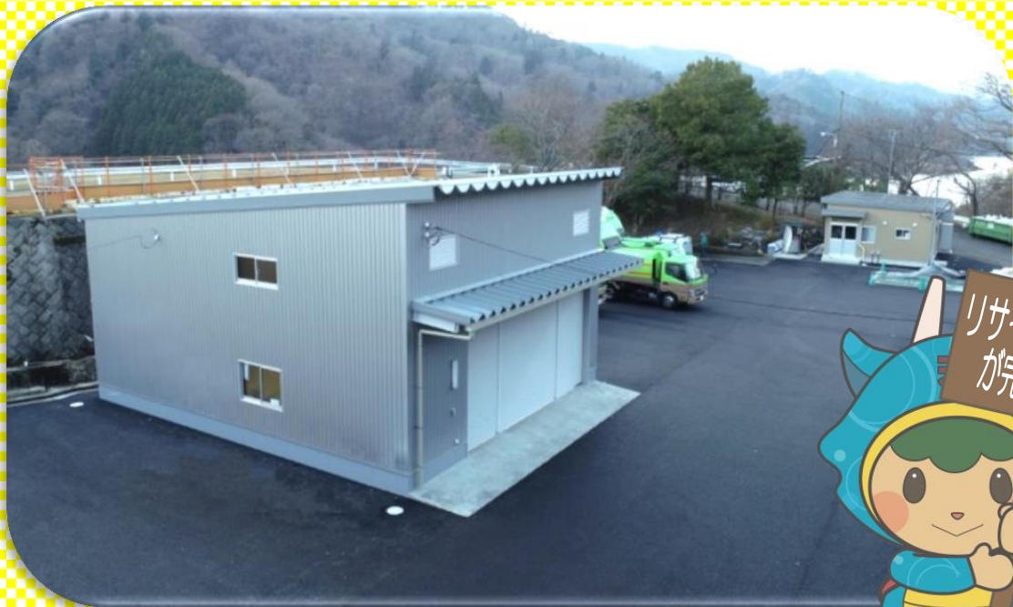
清川村リサイクルセンター
