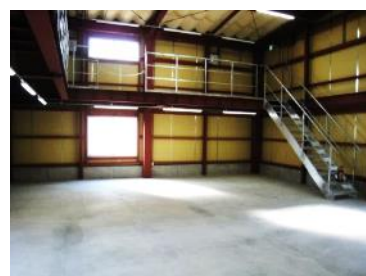
リサイクルセンター内部
