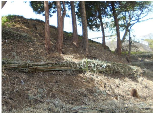
（森林整備施工後の様子）
