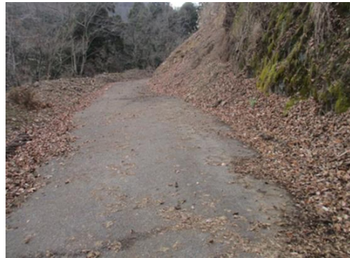
（林道付近の施工後の様子）
