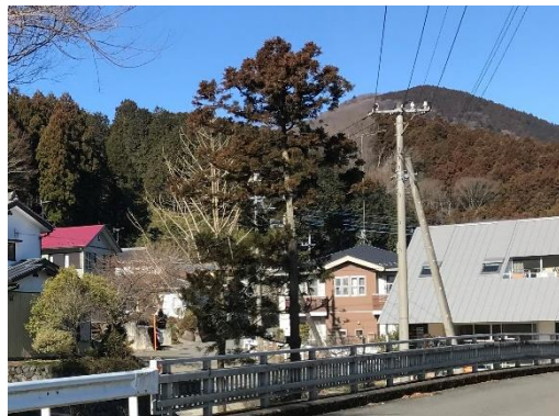
（県道付近の施工後の様子）
