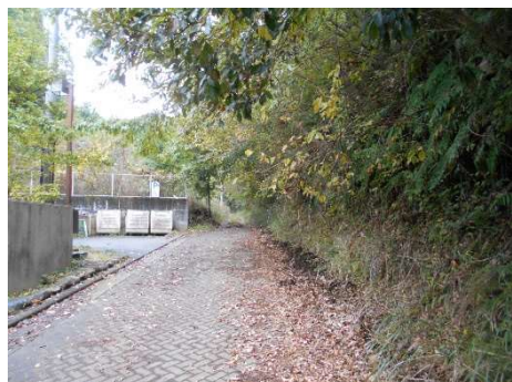
（林道付近の施工前の様子）
