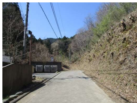
（林道付近の施工後の様子）
