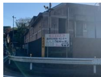
舟沢地区（圧送センター）
