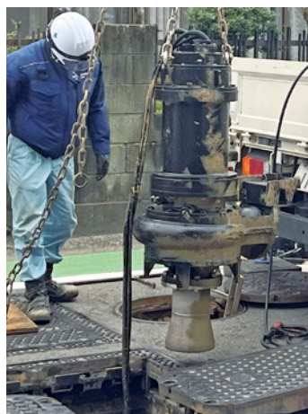
引き上げたポンプ
