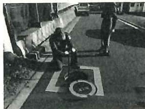
◆消防水利点検
