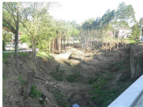
（森林整備施工前の様子）
