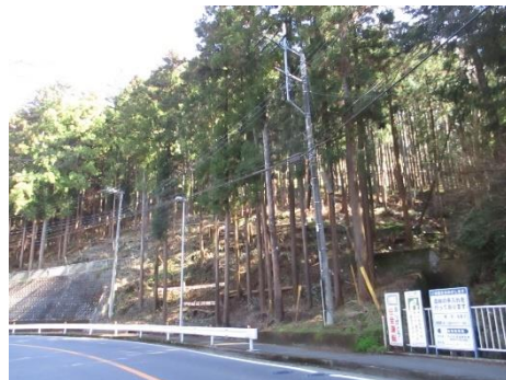
（県道付近の施工後の様子）
