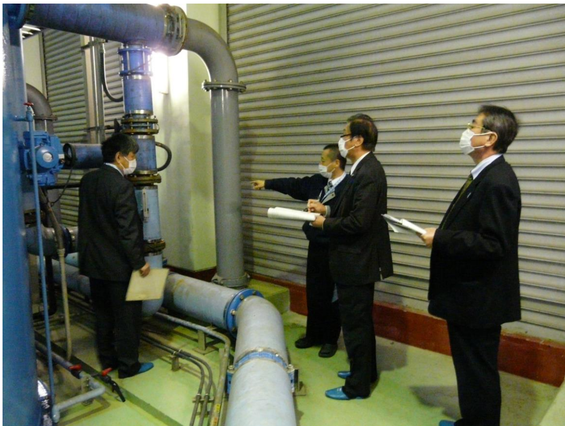
現地調査の様子①（宮ヶ瀬浄水場ろ過機改修工事）
