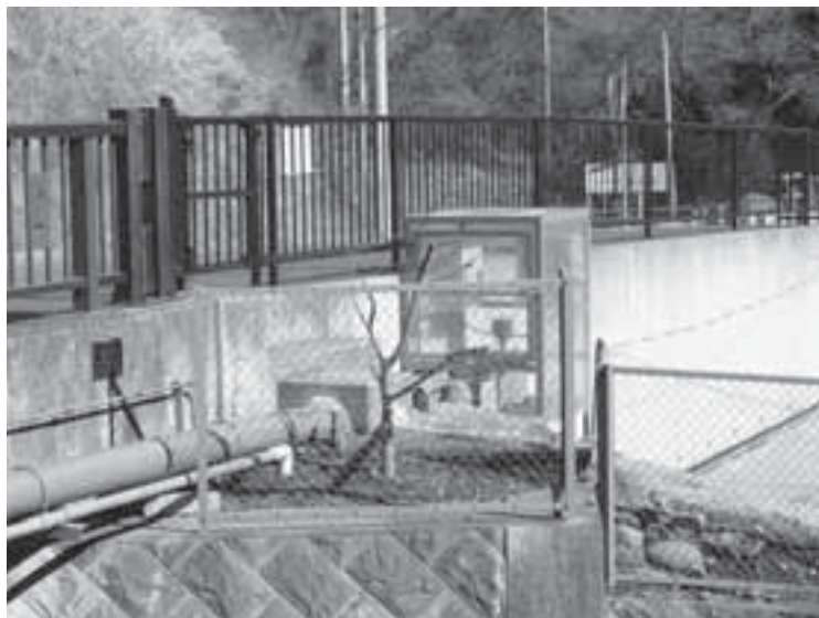
厚木市七沢地区のマイクロ水力発電所
